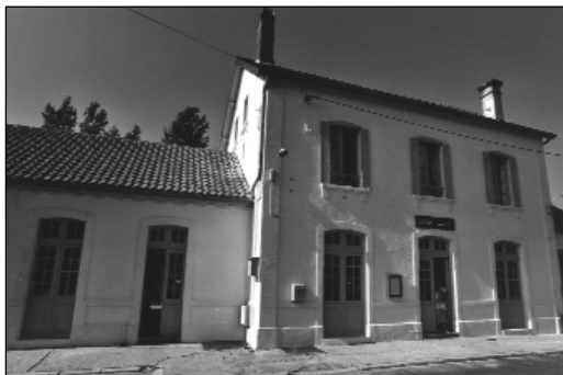
Gare de Jarnac rénovée. Cliché Conseil régional
